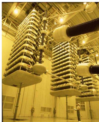
Figura 3.33 Válvula de tiristores em sistema HVDC
