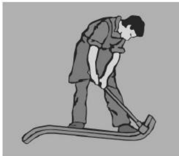
Figura 106 – Curvando o eletroduto.
