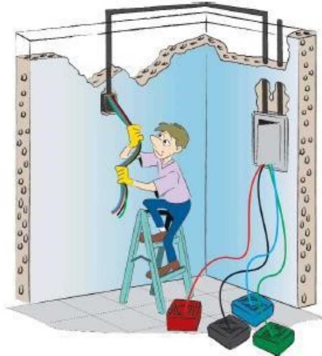
Figura 101 – Tracionando condutores.
