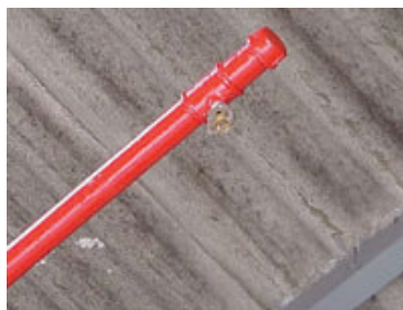
Figura 35. Bico de water spray .
