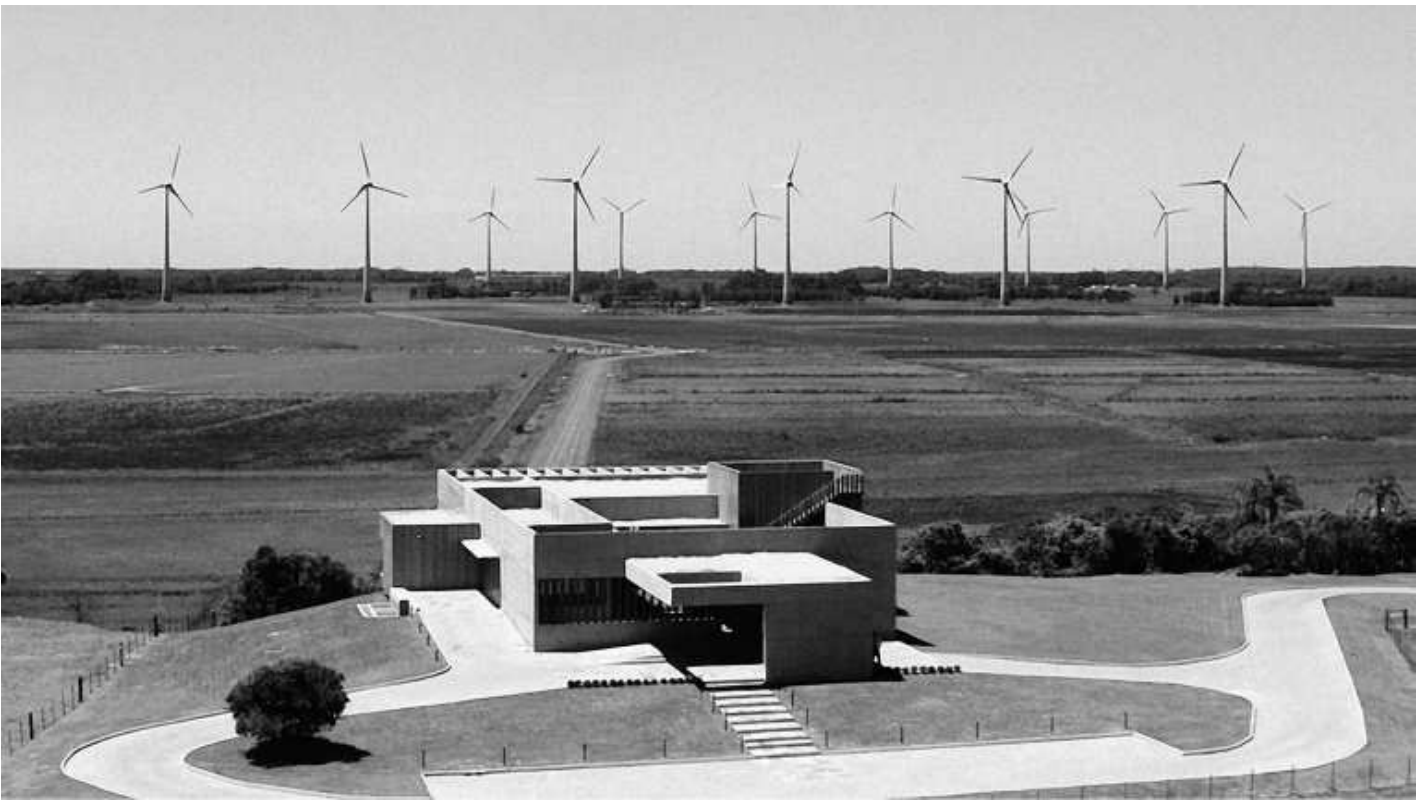
Parque eólico de Osório (RS). (Cortesia da Enerfín, Espanha.)
