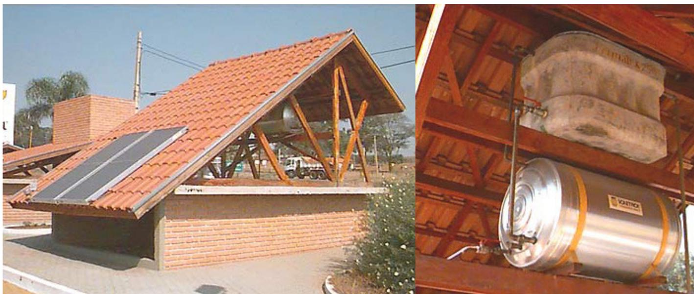
Na forma tradicional de instalação, o boiler deve se situar entre o reservatório e as placas de aquecimento como mostra as fotos e a figura. O princípio utilizado é o do termosifão. Acompanhe a figura: A água sai do boiler (tubo azul) e entra na parte inferior das placas (coletores solares). Pelo
