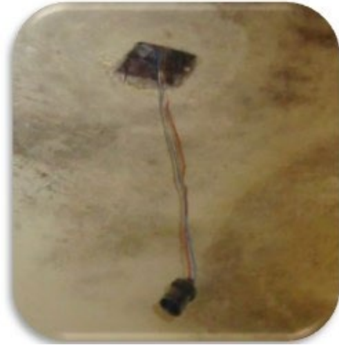
Infiltrações e Goteiras também causam fuga de corrente!
