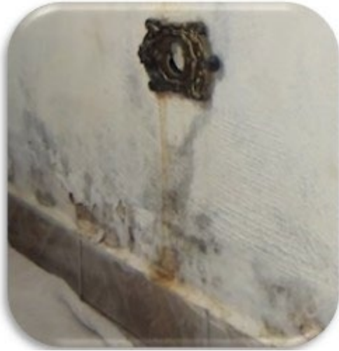
Infiltrações e Goteiras também causam fuga de corrente!
