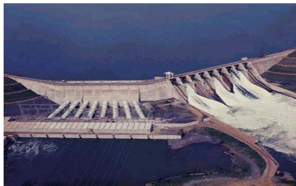
Figura 2.20 Vista aérea de barragem principal e de vertedouro.
