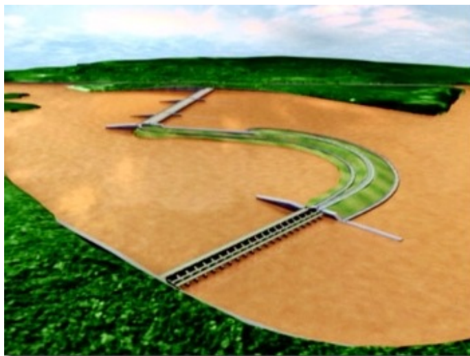
Figura 2.18 Esquema da usina Santo Antônio.
