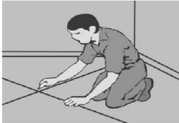
Figura 128 – Marcação da posição da lâmpada no chão.
