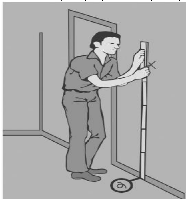
Figura 131 – Marcação da posição do interruptor na parede.
