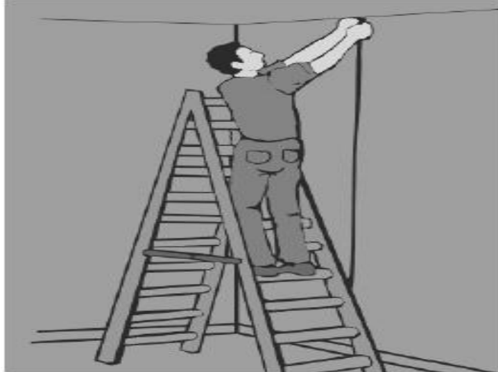
Figura 132 – Marcação do caminho do eletroduto na parede.
