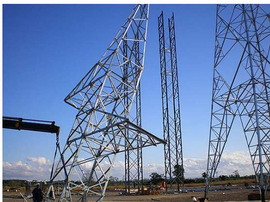
Figura 12.4 – Montagem da cabeça da torre.
