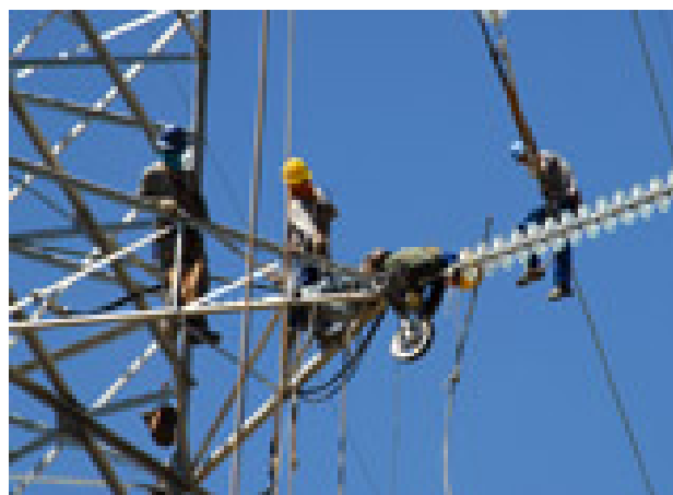
Figura 12.7 – Instalação de cabos condutores de linha de transmissão.
