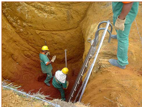
Figura 12.1 – Funcionários fazendo a escavação para fundação de torre de transmissão.
