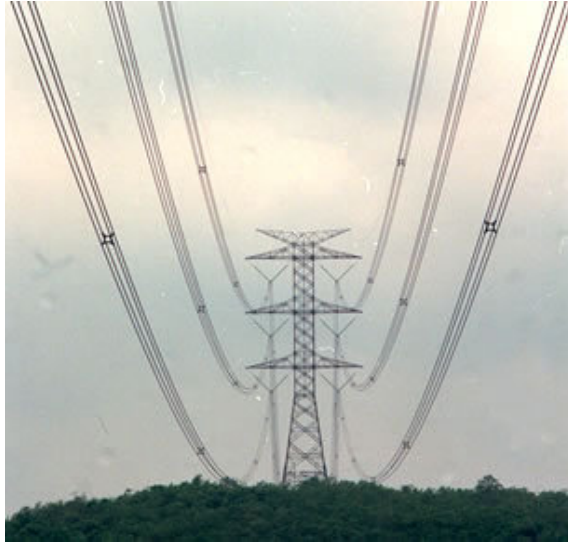
Figura 6.2.2 – Linha de transmissão de circuito duplo.
