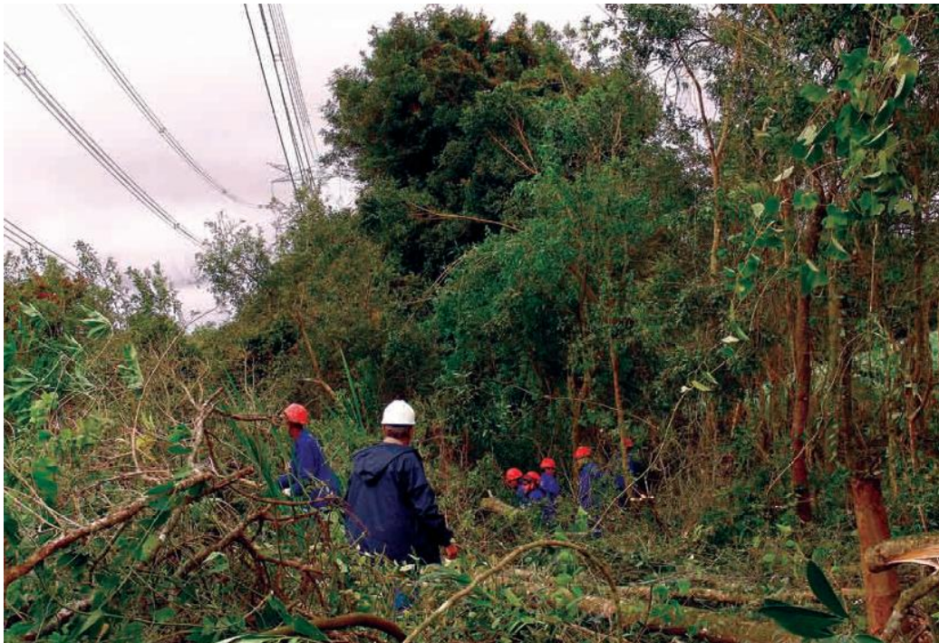
Figura 12.1 – Manutenção do terreno de uma linha de transmissão.
