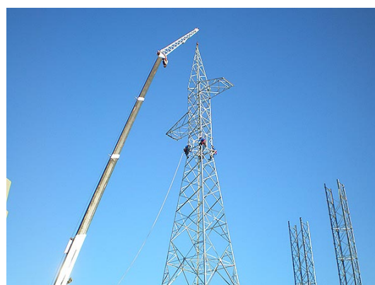
Figura 12.5 – Finalização da montagem da torre.
