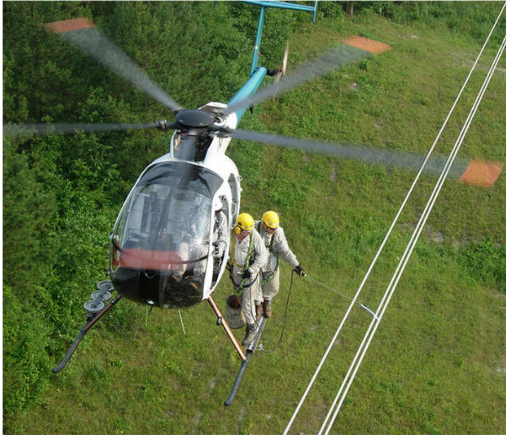
Figura 12.4 – Manutenção em linha de transmissão energizada de 500kV
