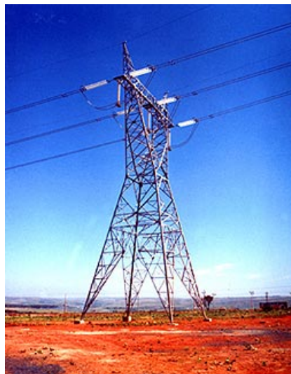
Figura 6.2.1 – Linha de transmissão de circuito simples
