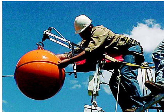
Figura 12.8 – Instalação de esfera de sinalização.
