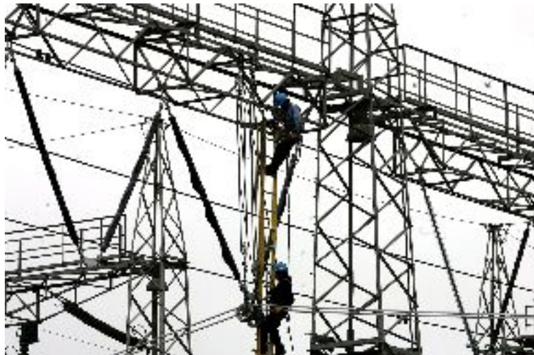
Figura 12.6 – Instalação de cabos condutores de linha de transmissão.
