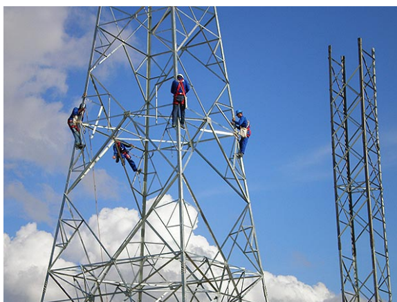
Figura 12.3 – Montagem do corpo da torre.
