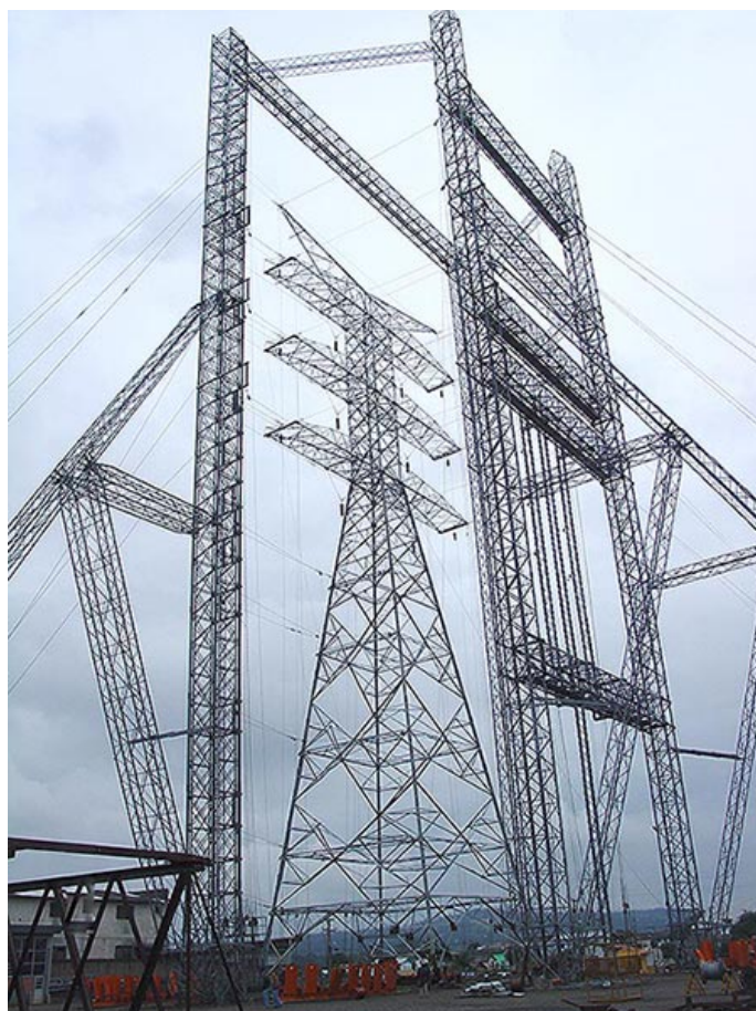
Figura 10.1.1 – Ensaio de carga em estrutura de linha de transmissão.
