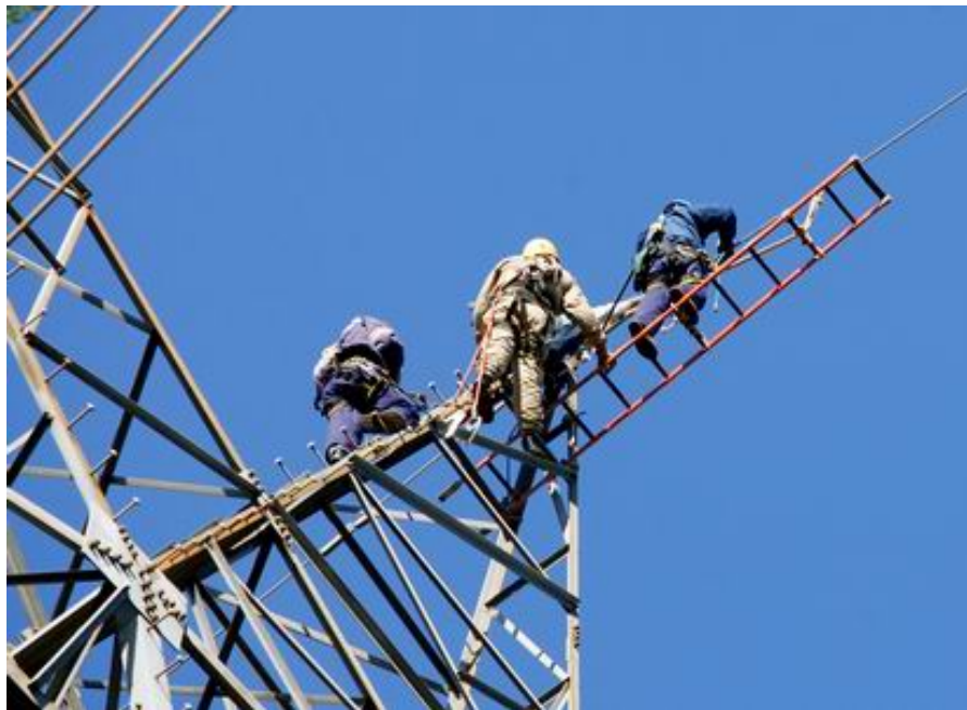
Figura 12.2 – Manutenção em torre de transmissão de energia elétrica.
