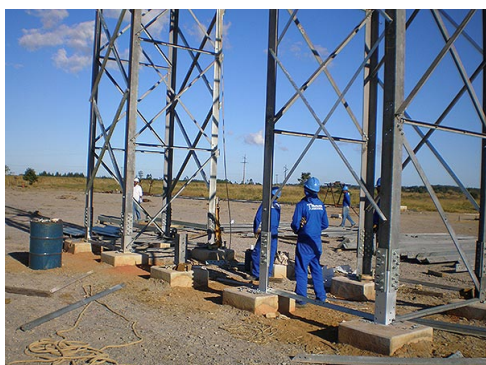
Figura 12.2 – Montagem da base da torre.
