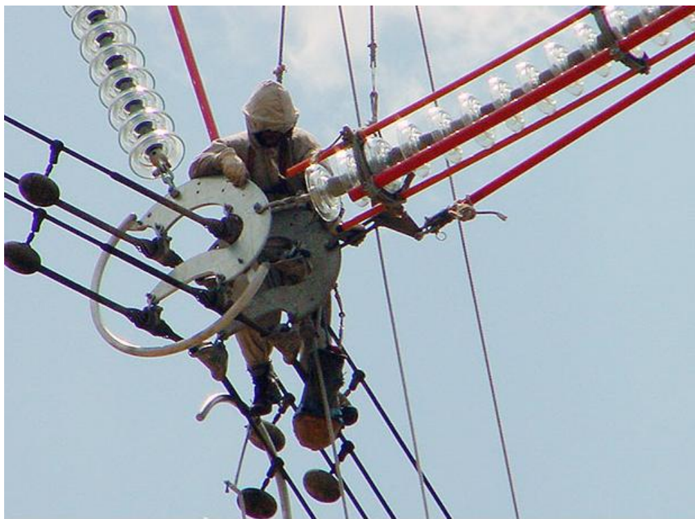
Figura 12.3 – Manutenção de isoladores em linha de 500kV.
